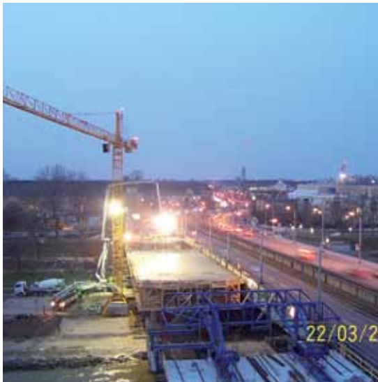
Betonage im 2. Bauabschnitt im März 2006.
