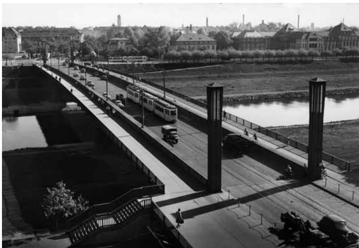
Die Original-Stahlbrücke von 1926, fotografiert im Jahr 1958.
