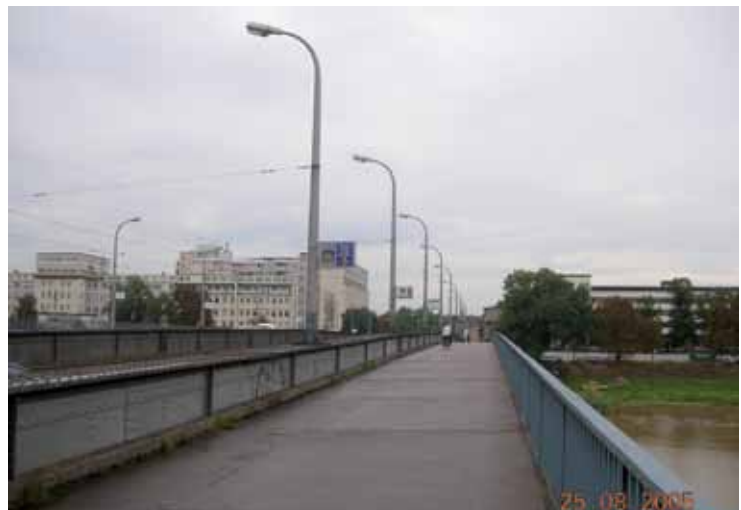
Brückenunteransicht und Fußgängerweg im Jahr 2005.
