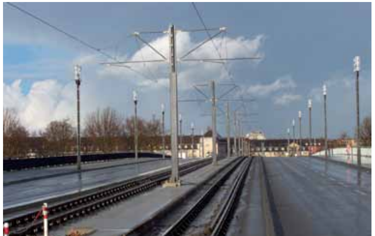
Plangleichheit der beiden Brückendecks.
