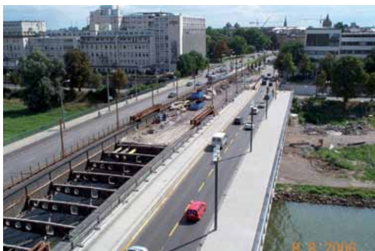
Der spektakuläre Abbruch der alten Brücke wurde während des laufenden Verkehrs durchgeführt.
