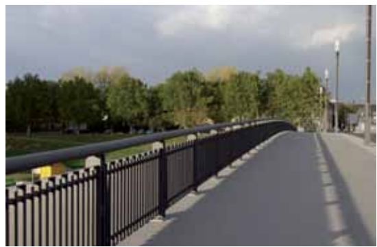
Geländer, Geh- und Radweg der neuen Brücke.
