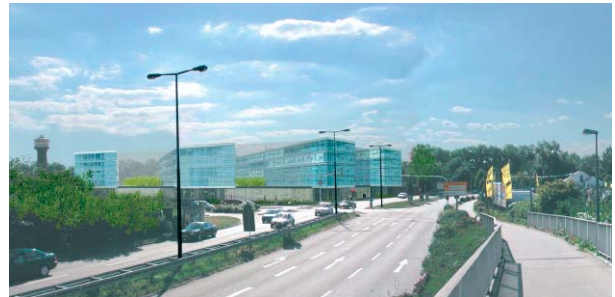
Das neue MAFINEX-Technologiezentrum wird auf dem ehemaligen John-Deere-Gießereigelände entstehen.
