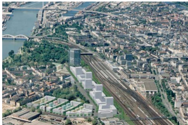
Ein neues Stadtquartier am Hauptbahnhof entsteht.
